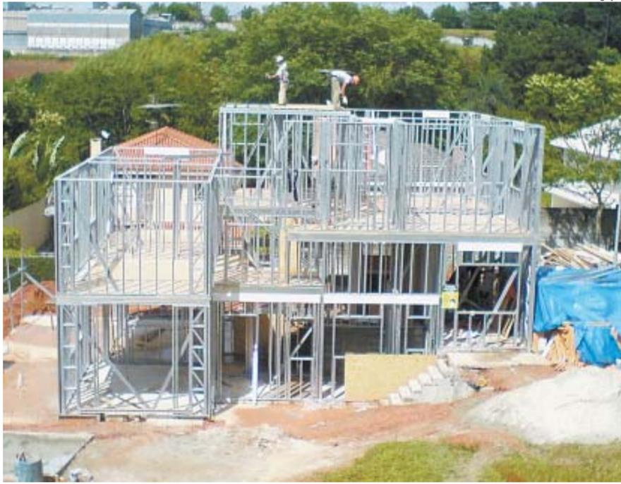
Obra com steel frame, estrutura metálica de aço leve, totalmente reciclável, que permite a escolha do acabamento
